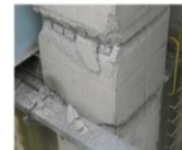
堰門柱のせん断破壊の事例 ～妙見堰(2004,新潟県)～
