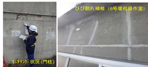
ひび割れ箇所のモニタリング及び補修の状況
