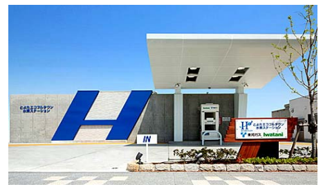
とよたエコフルタウン水素ステーション
