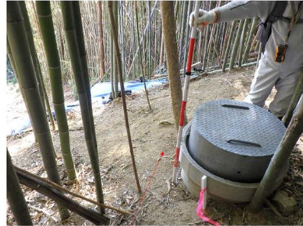
②④ 空気弁付近から斜面下方に流水跡は見られない
