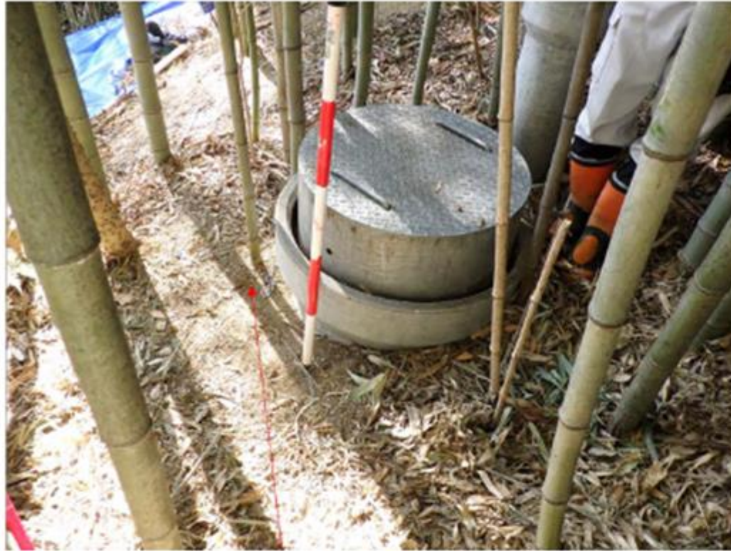
②③ 空気弁付近から斜面下方に流水跡は見られない
