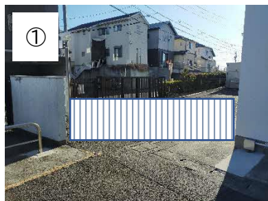
ペット用フェンスを設置
