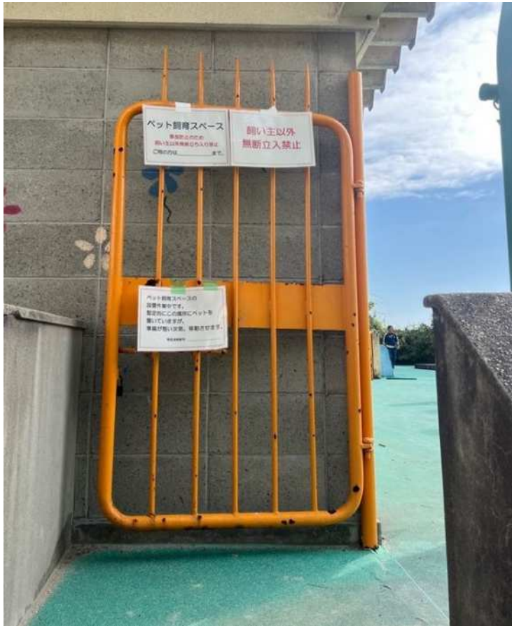
ペット避難スペース 入口
