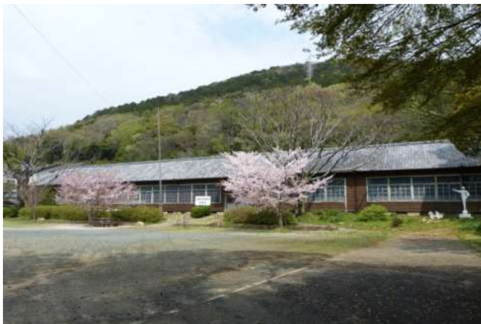
本棟正面 南から（豊橋市教委提供）
