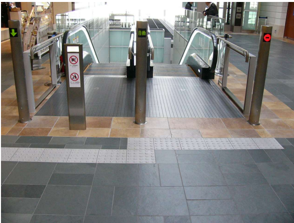
エスカレーターの整備例
