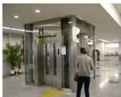
エレベーターの設置
