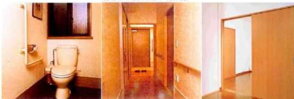
手すりの設置
