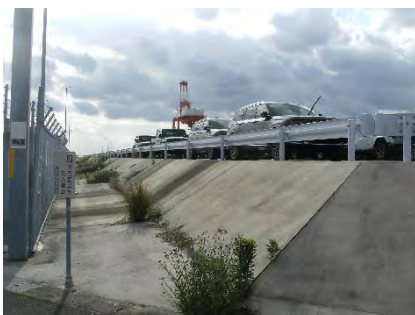
モータープール嵩上げ (愛知県豊橋市) 資料：愛知県
