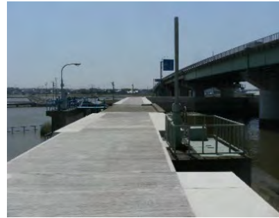
堤防の耐震化（三河港海岸：愛知県豊橋市）
