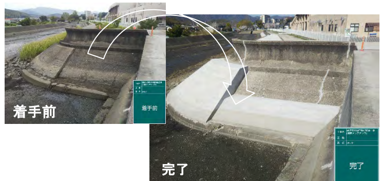
堤防の補修 (蒲郡海岸：愛知県蒲郡市)
