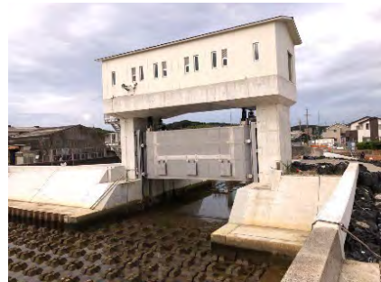
水門の改築(耐震化、自動閉鎖化) (美浜海岸布土川樋門：愛知県美浜町)
