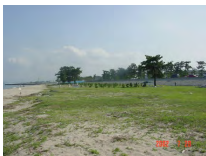
香良洲地区海岸（三重県津市）
