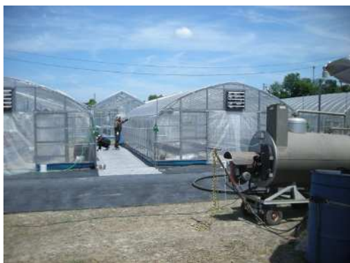
ボイラーで栽培ベッドに蒸気を送り込んで土を消毒
