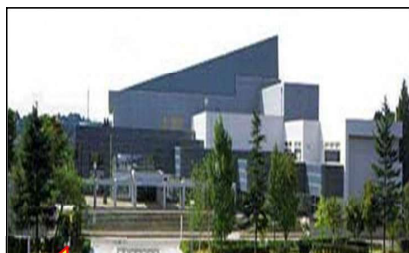
須賀川市文化センター【改修前】
