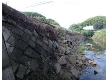
護岸整備：施工前
