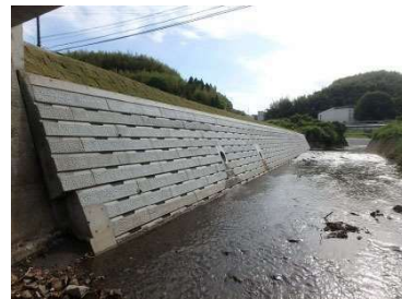
護岸整備：施工後
