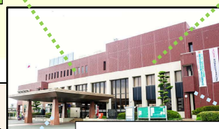
菊池市役所泗水支所
