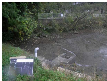
ため池堤体整備：施工前
