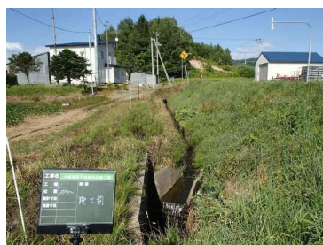
水路整備：施工前
