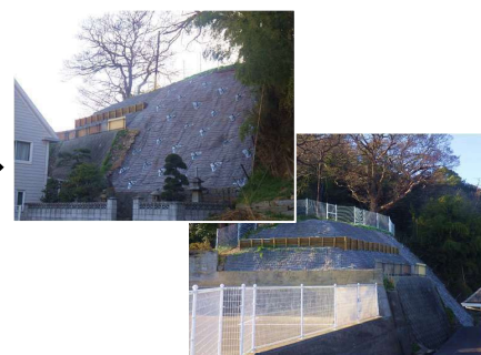
急傾斜地法面对策：施工後
