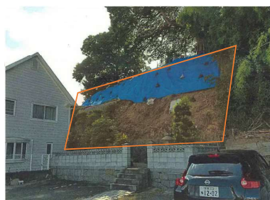
急傾斜地法面对策：施工前
