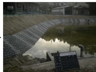
ため池堤体整備：施工後
