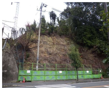
法面防護：施工前
