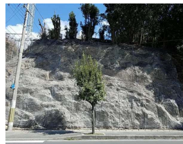
法面防護：施工後
