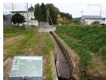
水路整備：施工後
