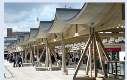
木造商業施設
