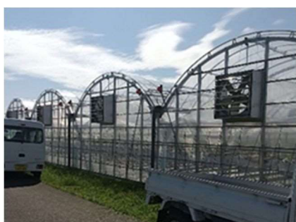
いちご栽培施設の新設（西尾市）
