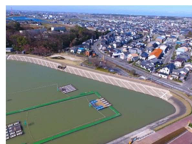
ため池の耐震対策
