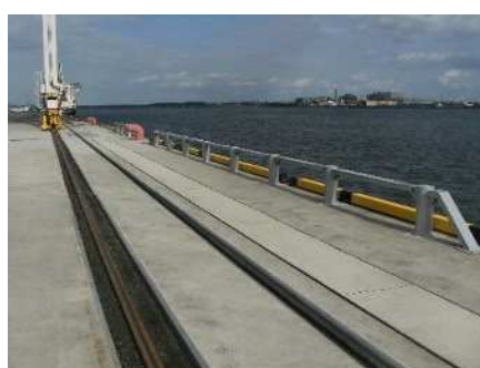
コンテナ流出防止柵の整備 （三河港 神野地区）
