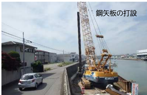
鋼矢板の打設 海岸堤防の耐震化 (衣浦港海岸)
