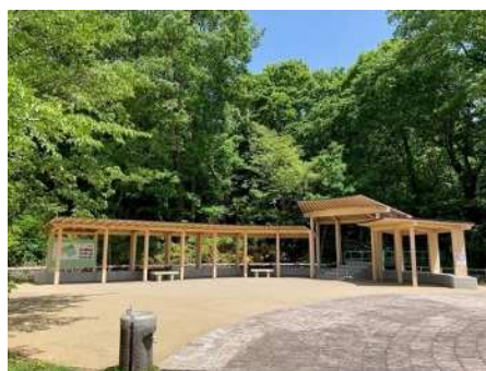
休憩所の更新（老朽化対策） （小幡緑地）
