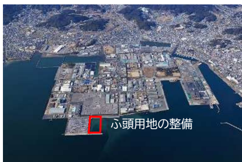
ふ頭用地の整備 (三河港蒲郡地区)
