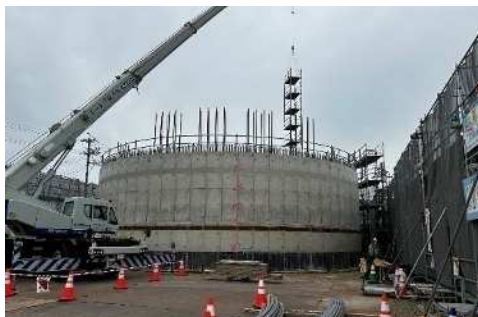
放水路整備（野府川（日光川2号放水路））
