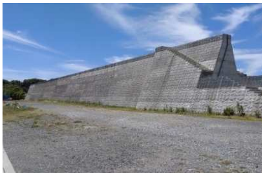
海岸堤防の新設 (赤羽根漁港海岸)
