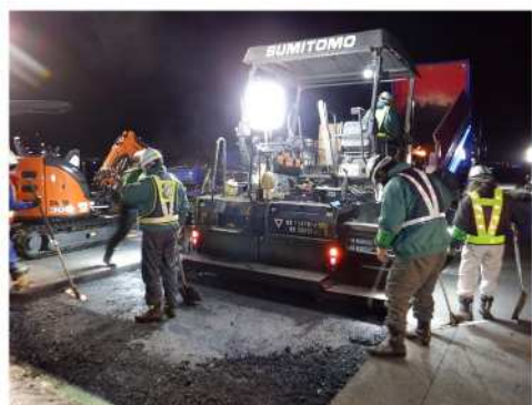
誘導路舗装の修繕
