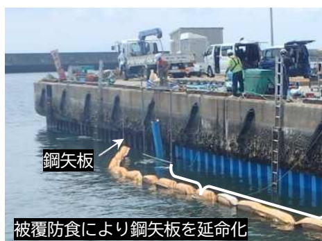
物揚場の補修 (西幡豆漁港)
