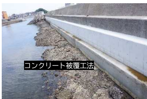
防波堤の補修 (師崎港)
