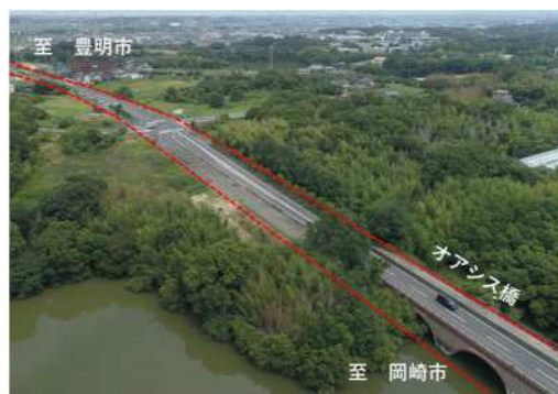
4 車線化 (県道名古屋岡崎線 刈谷市内)
