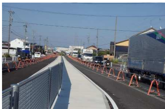
4 車線化 (国道 155 号 布袋拡幅)
