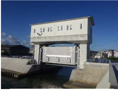
水門等の耐震化及び自動閉鎖化 (美浜海岸 布土川樋門)
