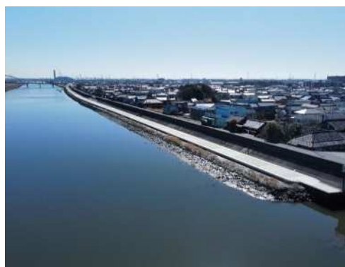
河川堤防の耐震化 （新川）
