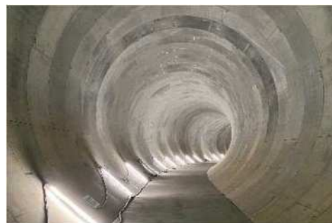
地下河川整備（柳生川）
