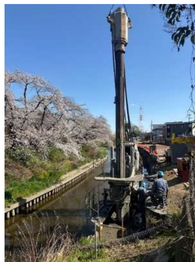
第1四半期4月の施工状況（五条川）
