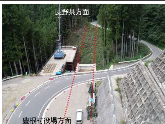
バイパス整備 (県道阿南東栄線)
