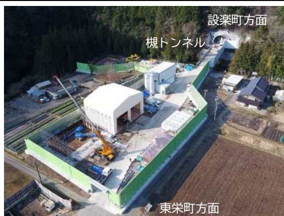
バイパス整備 (国道 473 号 梶トンネル)
