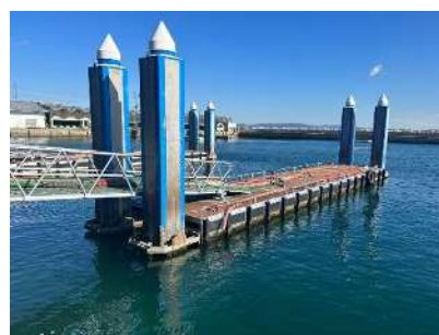
浮棧橋の新設（師崎漁港）
