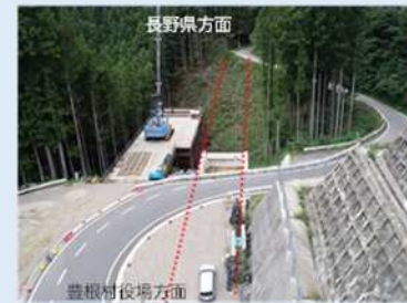
バイパス整備 （県道阿南東栄線）
