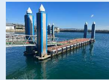
浮桟橋の新設（師崎漁港）
