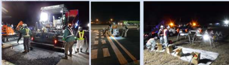
誘導路舗装の修繕
