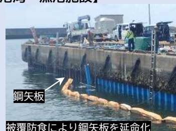
鋼矢板 被覆防食により鋼矢板を延命化 物揚場の補修 （西幡豆漁港）
