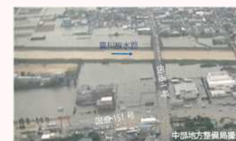
豊川市浸水状況 （2023年6月2日大雨による善光寺川（豊川市））
