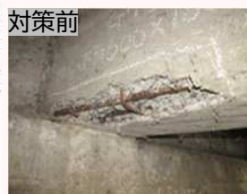
対策前 コンクリート桁の補修前
