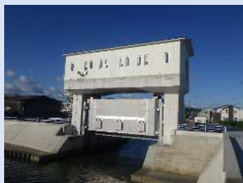
水門等の耐震化及び自動閉鎖化（美浜海岸 布土川樋門）
