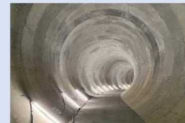
地下放水路整備 （柳生川）
