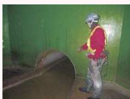
下水道の緊急点検
