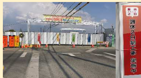
現場開所の状況（週休2日工事のPR）
