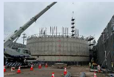
放水路整備 （野府川（日光川2号放水路））
