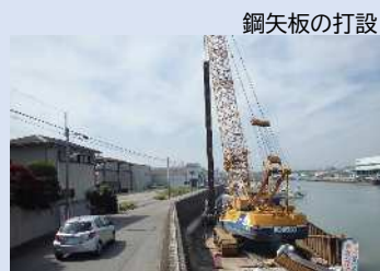
橋梁の耐震補強（県道豊橋渥美線 紙田川橋）
