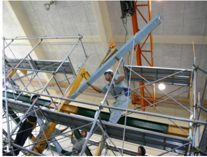
鉄骨建築の建て方
