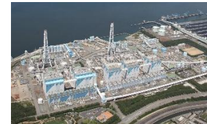
燃料アンモニアへの転換を目指す JERA碧南火力発電所
