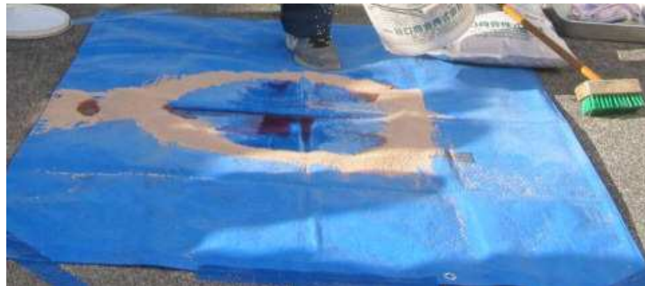
② 流下する方向を考慮しながら、油等の周囲を囲うように吸着剤を散布する
