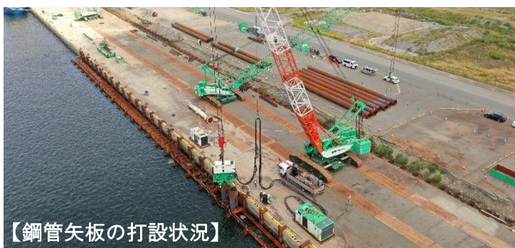
【耐震強化岸壁の整備】（田原市）
