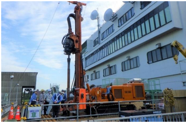
【排水機場の基礎の耐震化】
