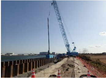
【東浦海岸 鋼矢板打設状況】
