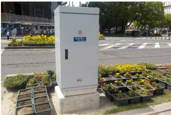
【自動起動式信号機電源付加装置】
