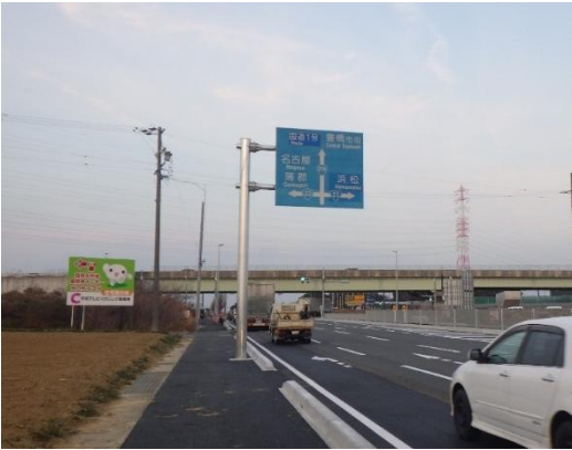
国道259号（植田バイパス）】 （豊橋市）
