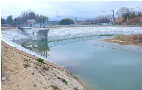
ごんどうじいけ 【権道路池（瀬戸市）整備完了状況】
