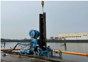
【新川 鋼矢板打設状況】
