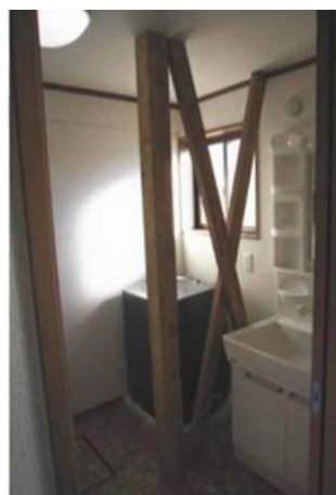
【戸建住宅の耐震改修】
