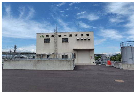
【整備完了状況】
