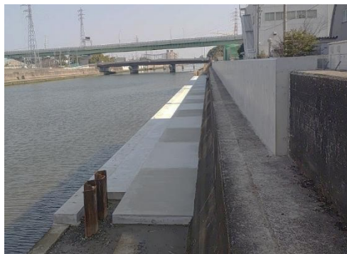
【防潮壁の地震・津波対策（大江ふ頭地区）】
