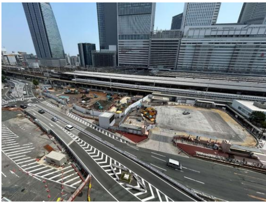
【名古屋駅（中央西工区）】
