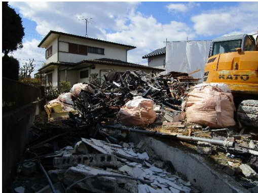
【解体工事現場の様子】
