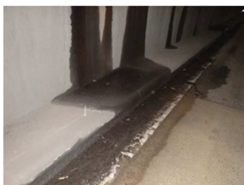
写真 6-33 路面の滞水
