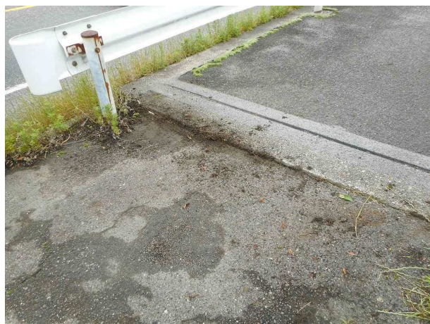
写真 6-16 橋面舗装の凹凸
