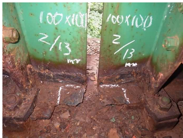
写真 6-19 桁端の腐食Ⅲ
