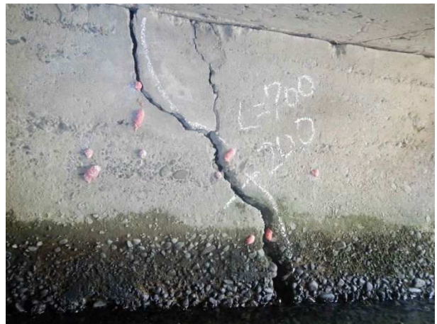
写真 6-27 縦壁 ひびわれ III
