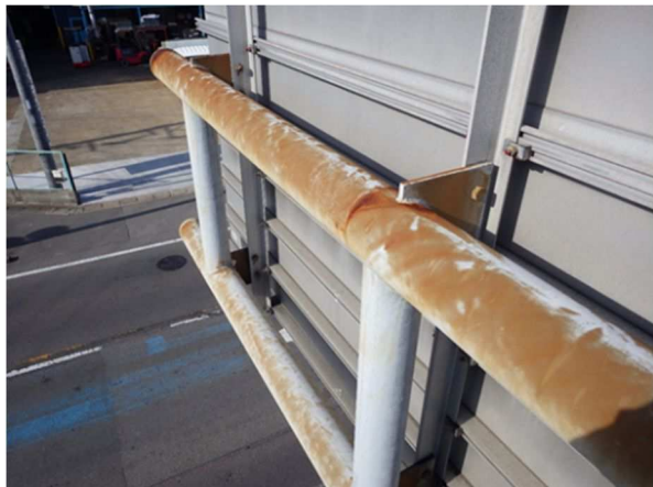
写真 6-49 横梁の腐食
