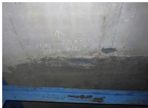
写真 6-4 鋼橋床版のうき (かぶり不足)
