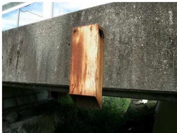
写真 6-14 排水管の腐食
