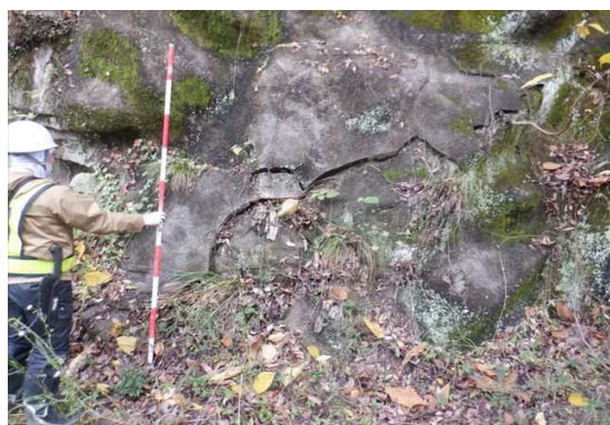
写真 6-45 モルタル吹付工の剥離
