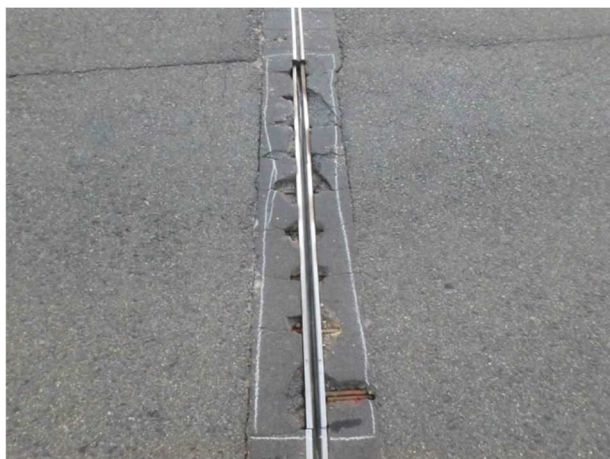
写真 6-17 伸縮装置の変形
