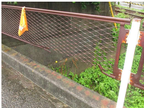
写真 6-13 防護柵の変形
