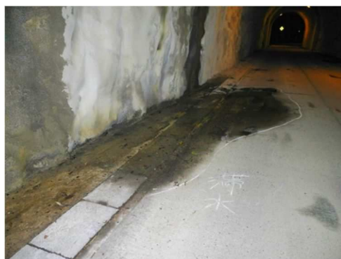
写真 6-31 路面の滞水
