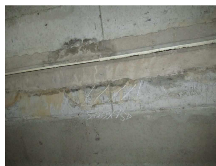
写真 6-6 PC 橋床版のうき（施工不良）
