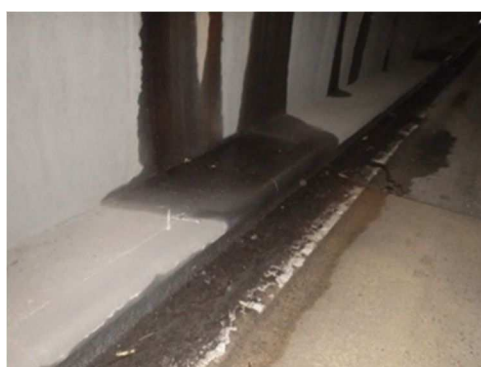
写真 6-33 路面の滞水
