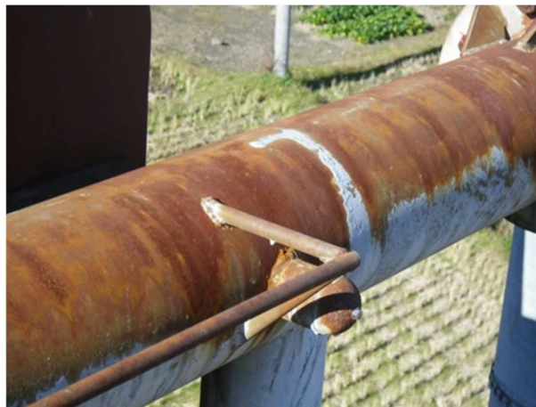
写真 6-53 横梁の腐食
