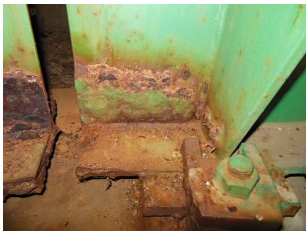
写真 6-18 桁端の腐食Ⅱ
