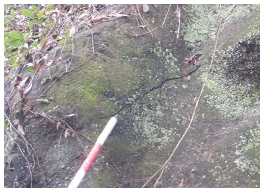
写真 6-46 モルタル吹付工のひびわれ
