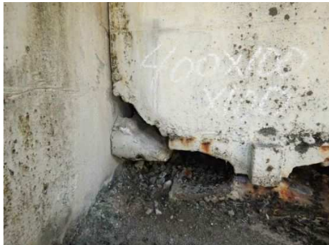
写真 6-7 RC 橋主桁の剝離・鉄筋露出 (中酸化)
