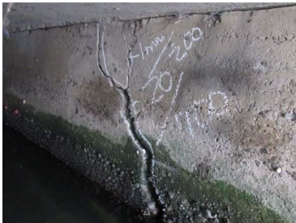
写真 6-26 縦壁 ひびわれ II
