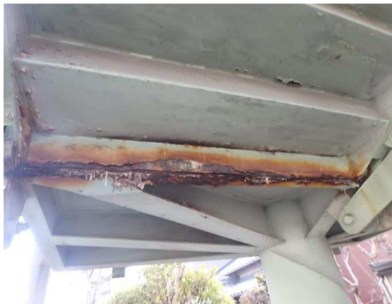
写真 6-43 階段桁の防食機能の劣化
