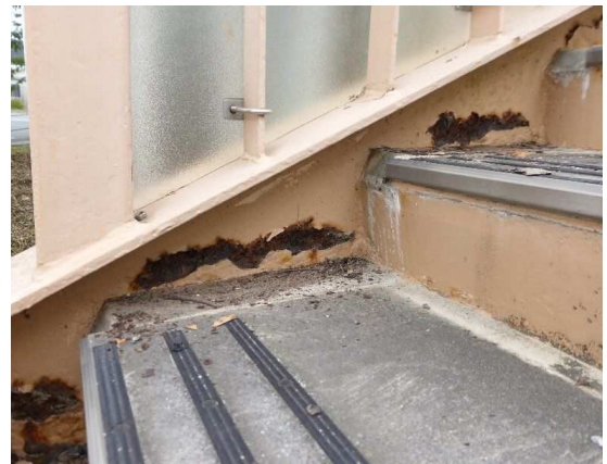
写真 6-44 階段桁の防食機能の劣化
