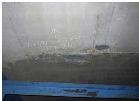
写真 6-4 鋼橋床版のうき (かぶり不足)
