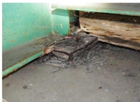
写真 6-1 鋼橋主桁の腐食 (端部の漏水)
