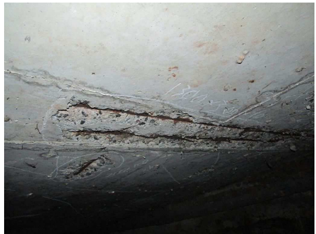
写真 6-25 床版 剥離・鉄筋露出 III
