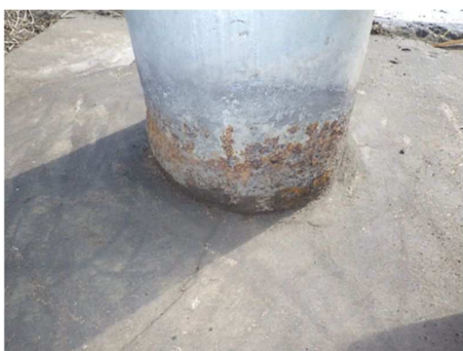
図 6-105 支柱 損傷発生状況
