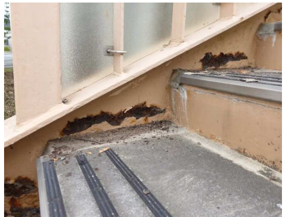
写真 6-44 階段桁の防食機能の劣化
