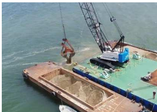
河川堆積砂等による干潟・浅場の造成
