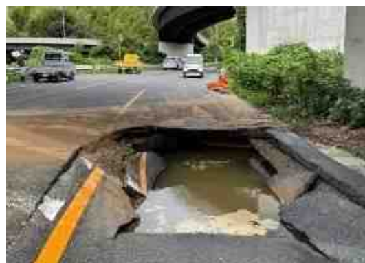
農業用管水路の漏水による道路陥没
