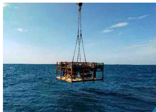
魚礁漁場整備のため海中に沈められる鋼製魚礁
