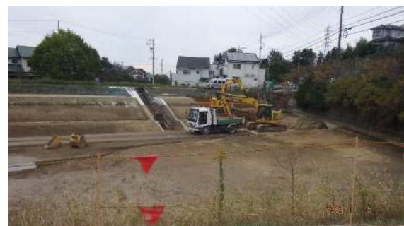
堤体押さえ盛土の施工状況 (防災ダム事業 明知地区 多羅釜池 池の内側)
