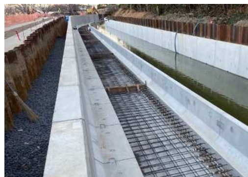
枝下用水幹線水路の改修工事 (枝下用水地区)
