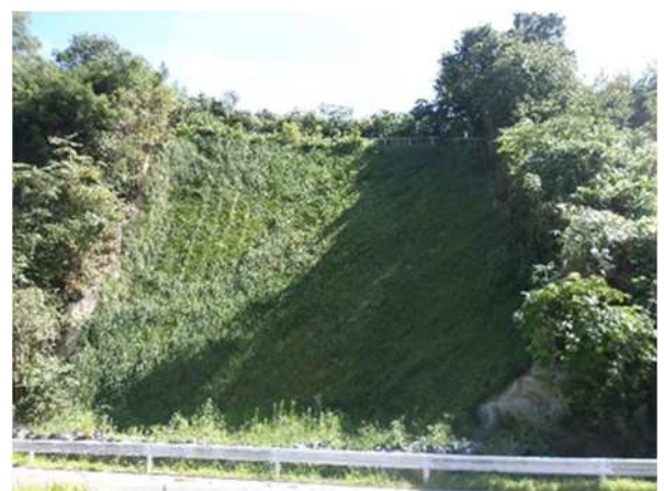
山腹崩壊地に施工した補強土工
