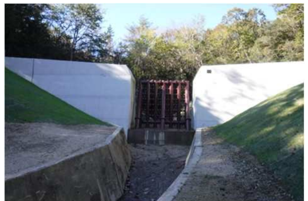
荒廃溪流に設置した治山ダム
