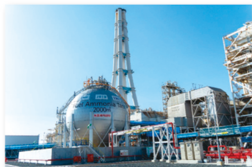
燃料アンモニアへの転換を目指すJERA碧南火力発電所
