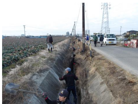
泥上げの作業風景
