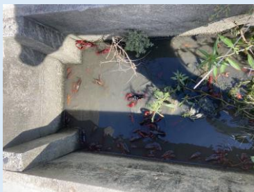
落水後の排水路の状況
