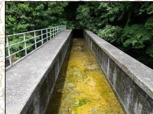
③ 相川水路橋に水が流れていく様子
