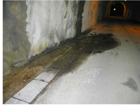
写真 6-31 路面の滞水
