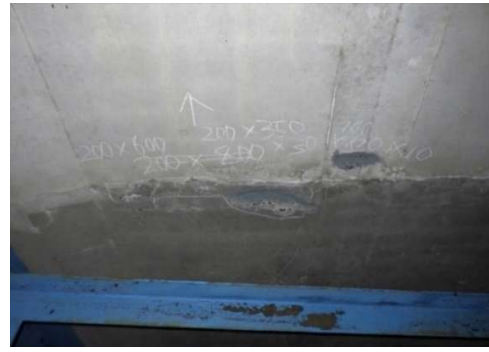
写真 6-4 鋼橋床版のうき (かぶり不足)
