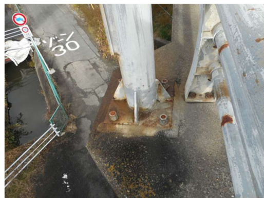
写真 6-52 基礎の腐食
