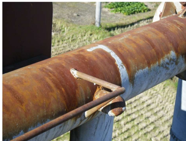
写真 6-53 横梁の腐食
