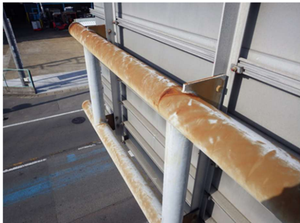
写真 6-49 横梁の腐食
