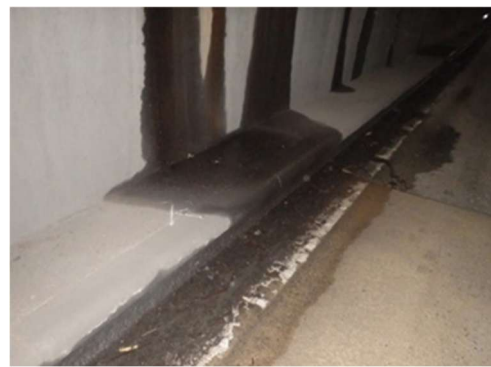
写真 6-33 路面の滞水
