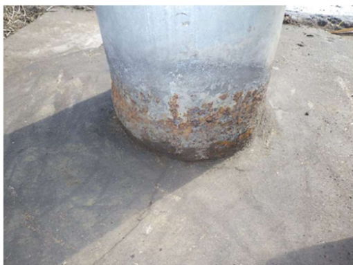
図 6-105 支柱 損傷発生状況
