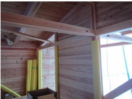
J パネル施工状況
