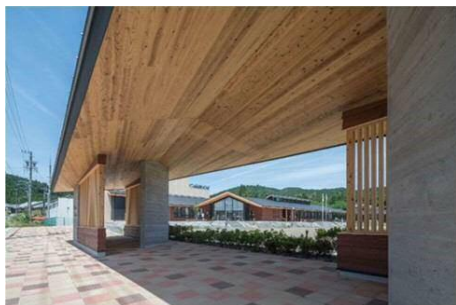
CLTの屋根で作られた正門
