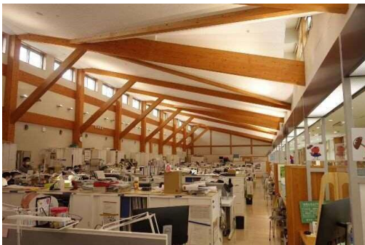
役場棟執務室は集成材梁による大空間
