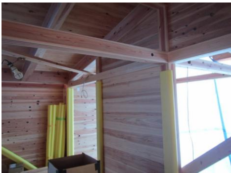
J パネル施工状況
