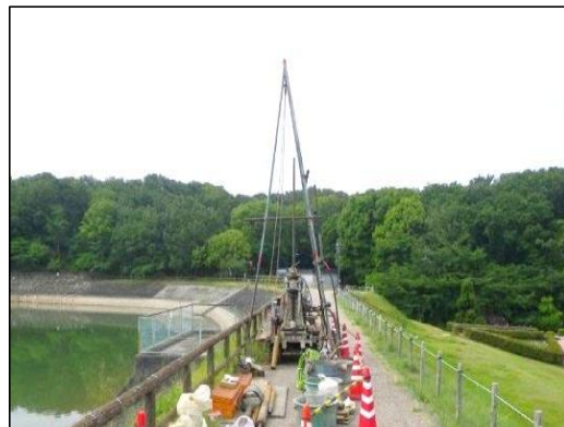
ため池堤体の土質調査：保田ヶ池
