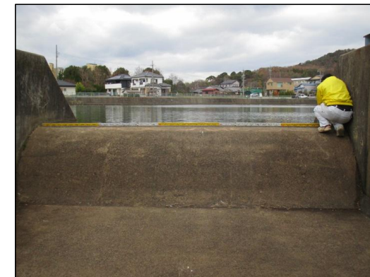
洪水吐の断面調査：徳ヶ池
