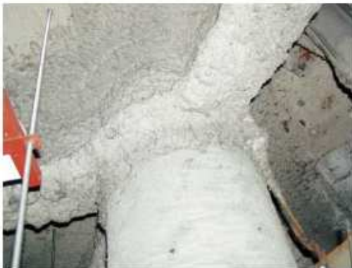
鉄骨耐火被覆
