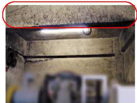
機械室吸音材
