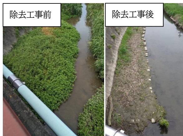
ナガエツルノゲイトウ除去工事前後の比較
