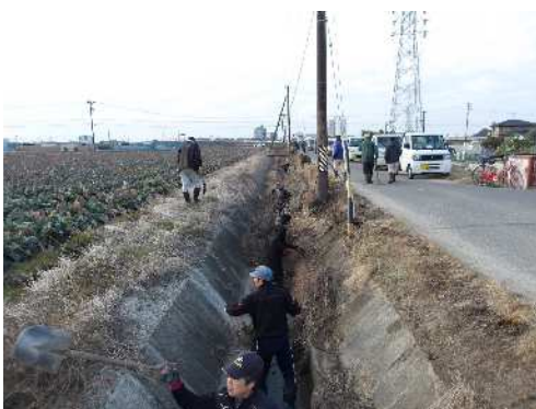
泥上げの作業風景
