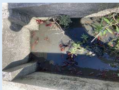
落水後の排水路の状況
