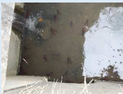
落水後の集水樹の状況
