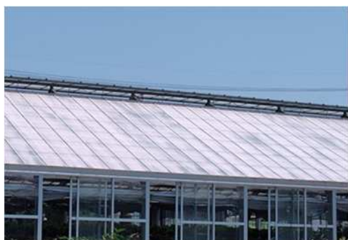
施設屋根への遮光・遮熱剤の塗布
