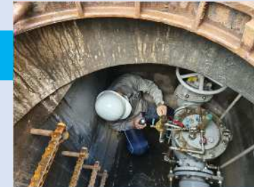
減圧弁開度変更作業状況 (蒲郡市)
