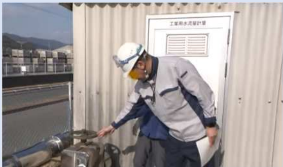
㊤受水量制御の実施状況
