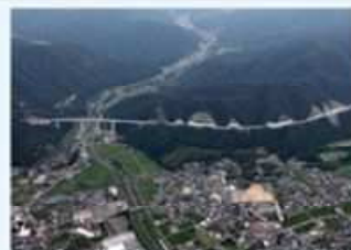
舞鶴若狭自動車道 敦賀衣振大橋(福井県敦賀市)
