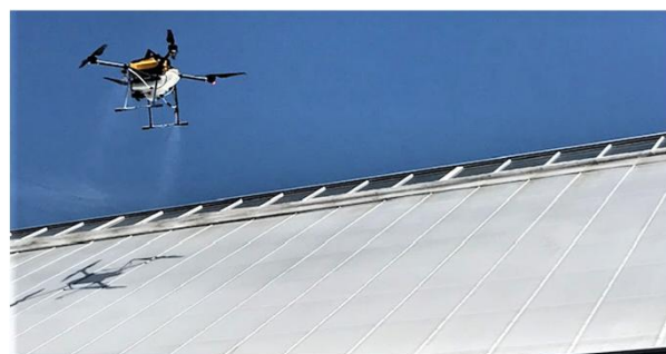
ドローンを用いた園芸ハウスへの遮熱剤の塗布
