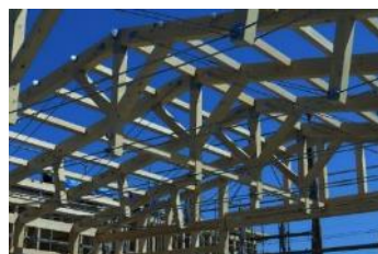
▲ 建設中の西棟内観
