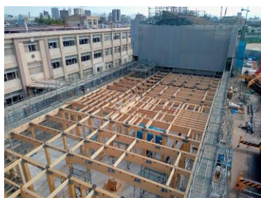
▲建築中の様子
