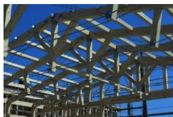
▲ 建設中の西棟内観
