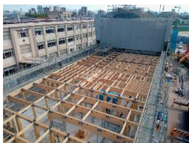
▲建築中の様子
