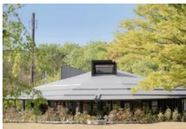
写真：Tezuka Architects
