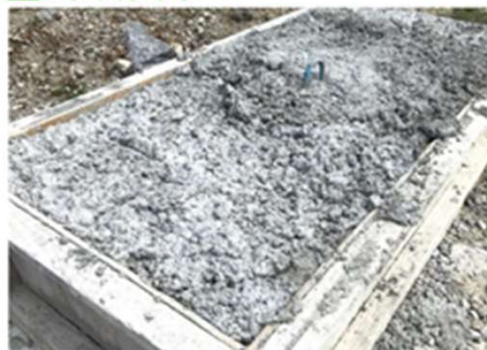
生コンスラッジ
