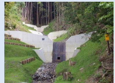
治山施設の整備
