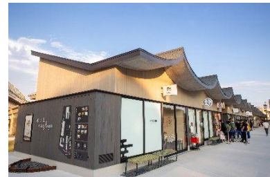
木造商業施設
