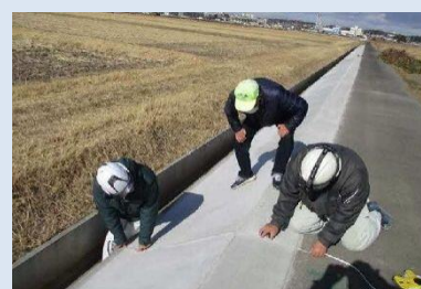
水路法面の補修
