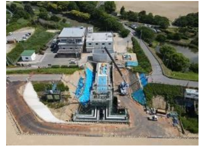
農業用排水機場
