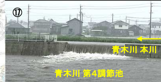
9月9日13:30 青木川本川から調節池への貯留状況
