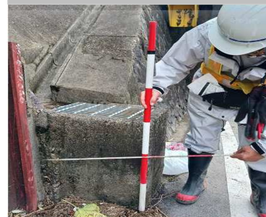
河川巡視 堤内地浸水状況の確認
