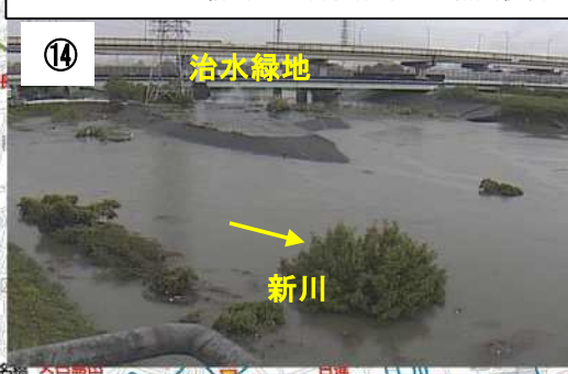
9月8日18:00 新川から治水緑地への流出状況
