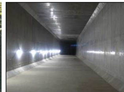
玉野放水路函体
