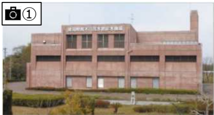
青木川放水路排水機場
