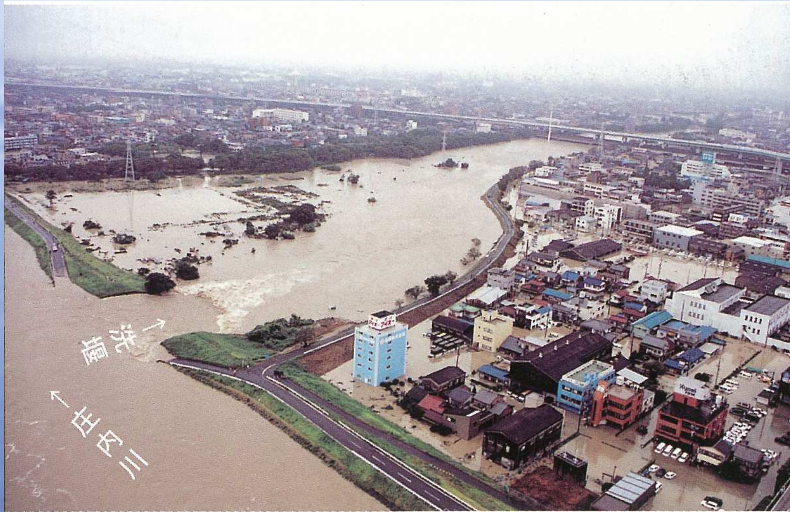
洗堰を越流して新川に流入する庄内川の洪水
