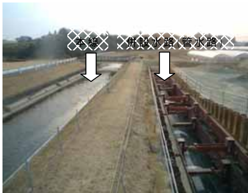
幹線水路の複線化工事状況（豊川用水二期事業）
