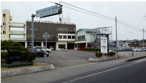
⑮犬山市消防本部（車両保管場所）
