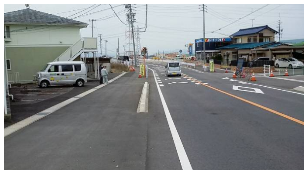
⑧仮設橋梁付近
